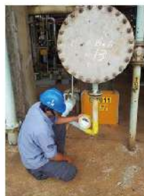
管線洩漏修復
